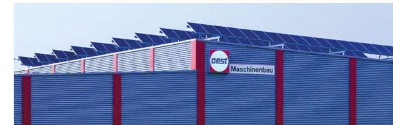
Auch eine leistungsstarke Photovoltaik-Anlage ist Bestandteil des Energiekonzeptes.
