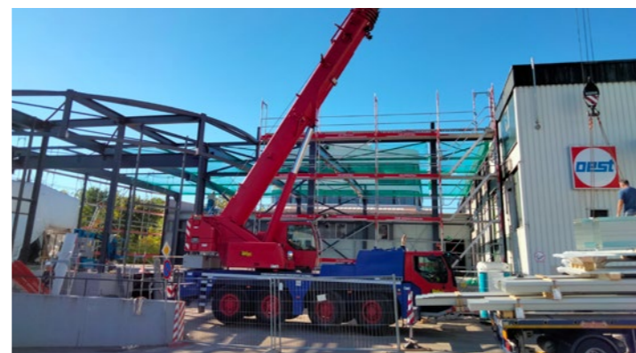
Neubau der Leergebinde-Halle im Georg Oest Mineralölwerk.
