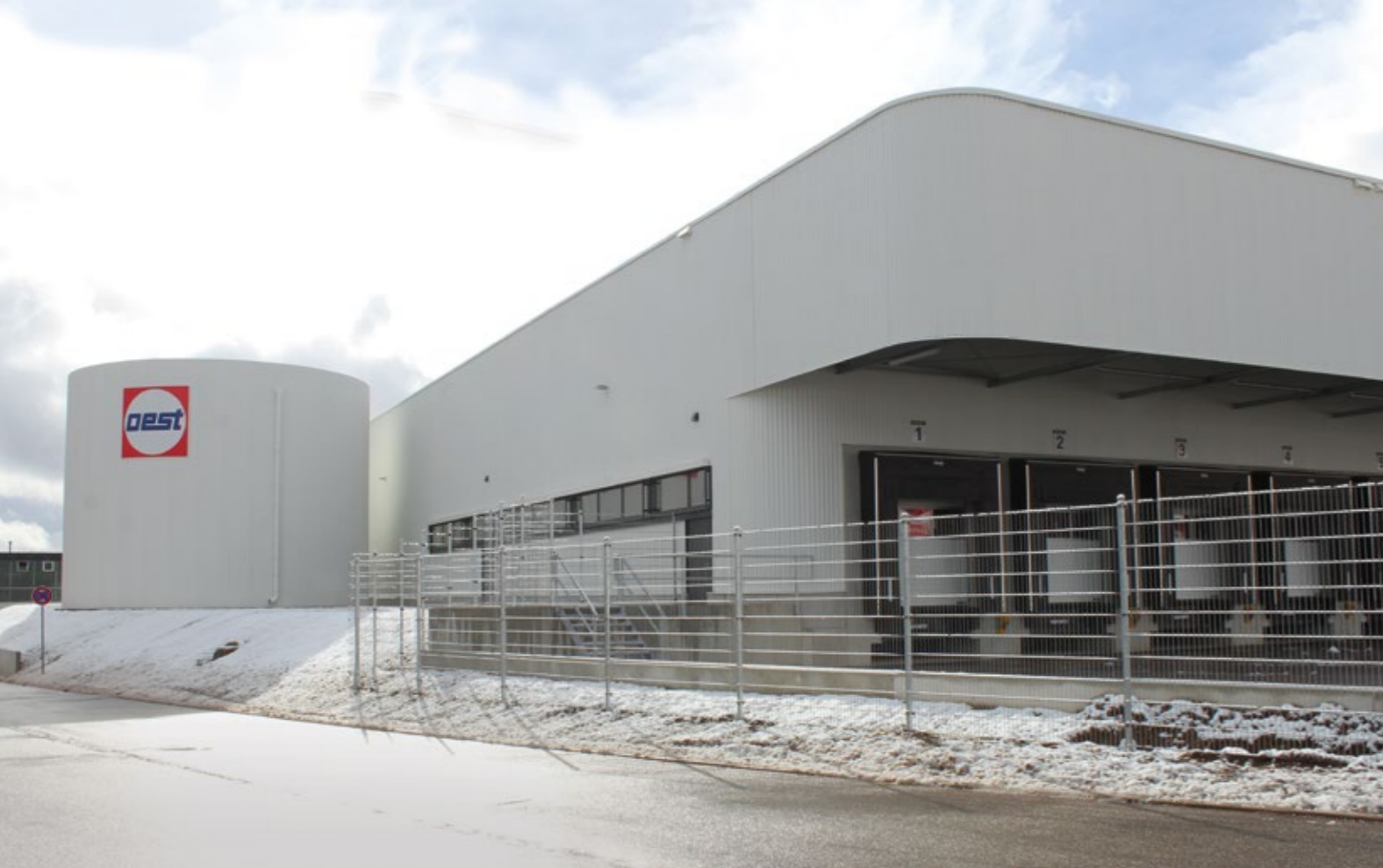
Die neue Lager- und Logistikhalle.
