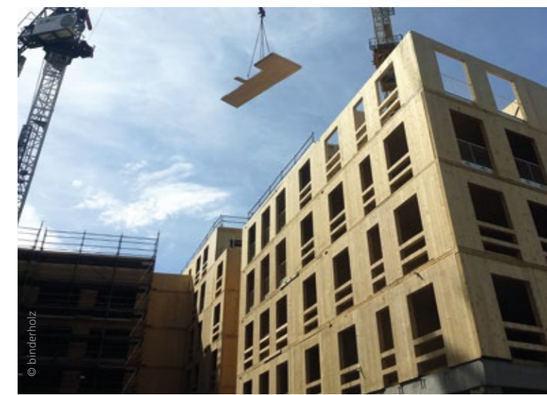
BSP - zukunftsweisender Bauwerkstoff.
