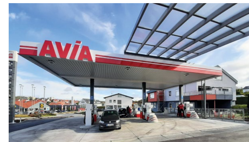
Nach nur drei Monaten Umbauzeit wiedereröffnet - die AVIA Tankstelle Meßstetten.
